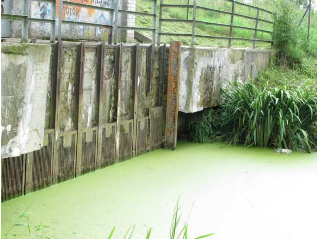
Fot. 17 Pompownia nr 2 -Wlot do komory czerpnej
