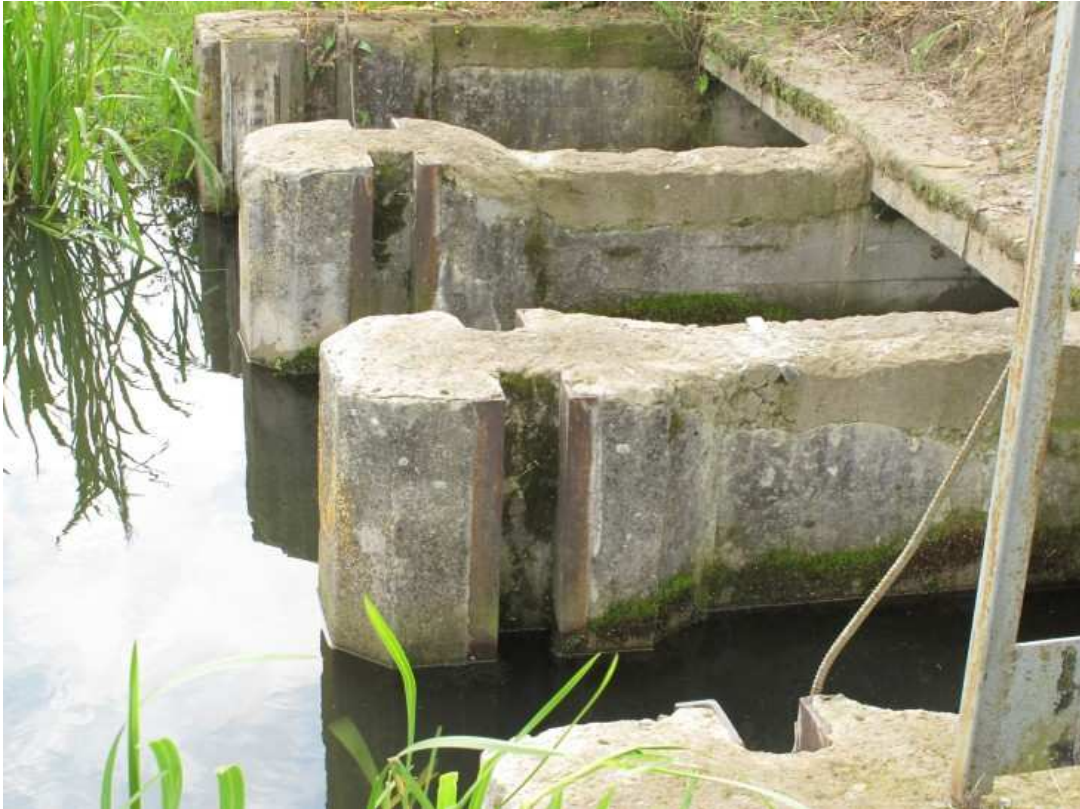
Fot. 15 Pompownia nr 2 -Dok wylotowy
