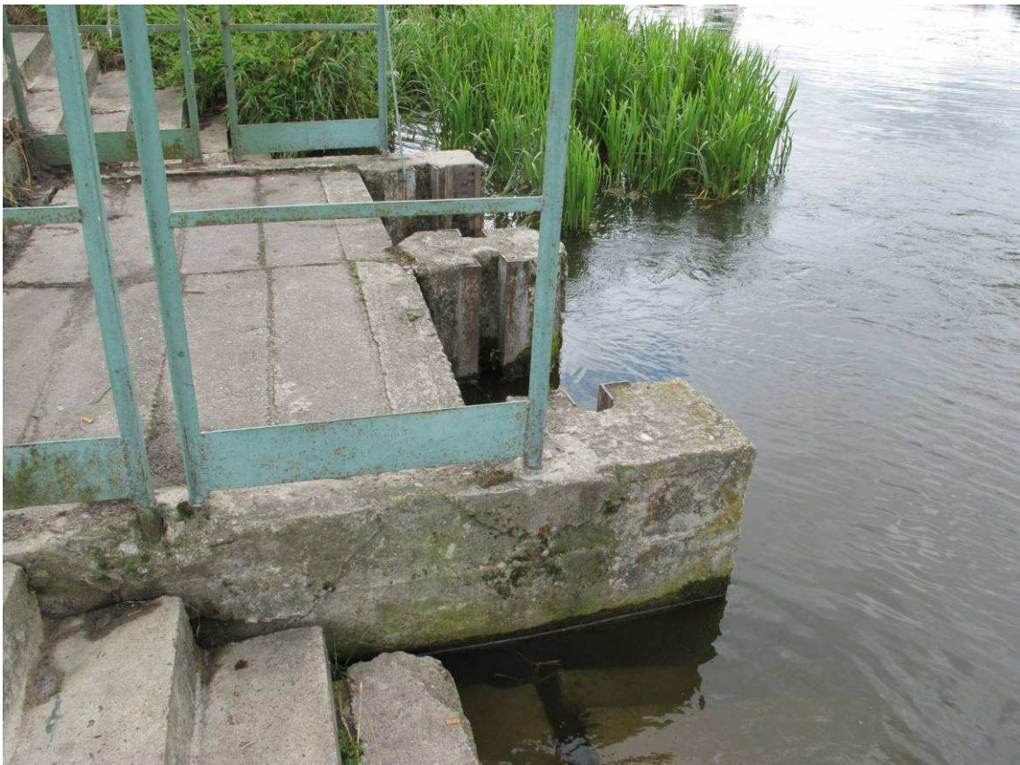
Fot. 8 Pompownia nr 1 - dok wylotowy
