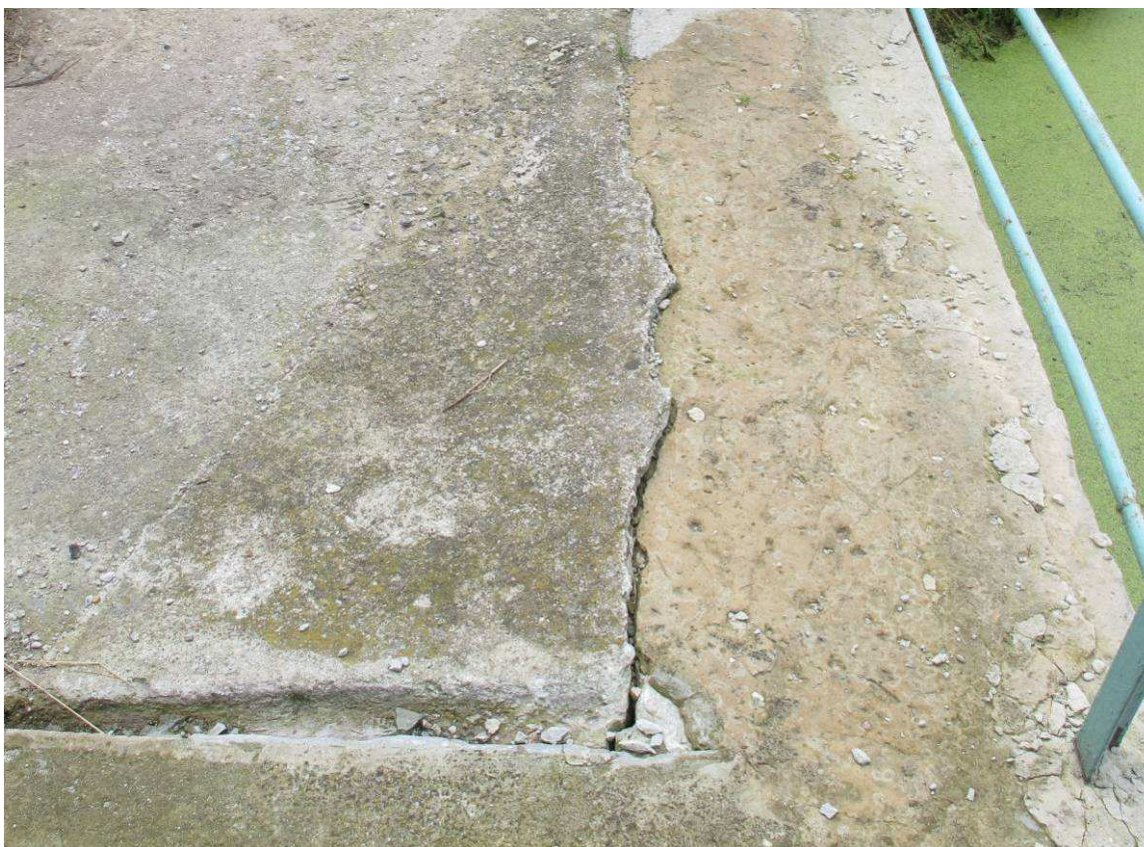
Fot. 12 Pompownia nr 1
