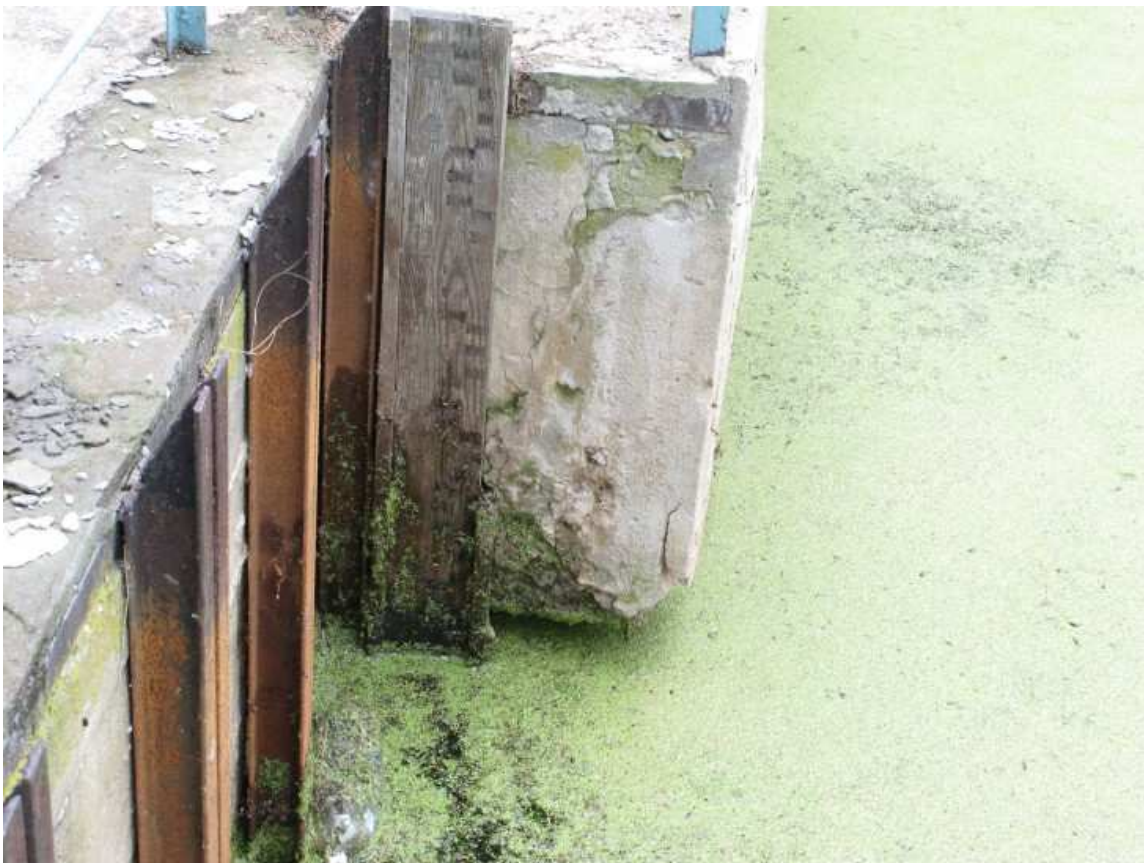
Fot. 11 Pompownia nr 1
