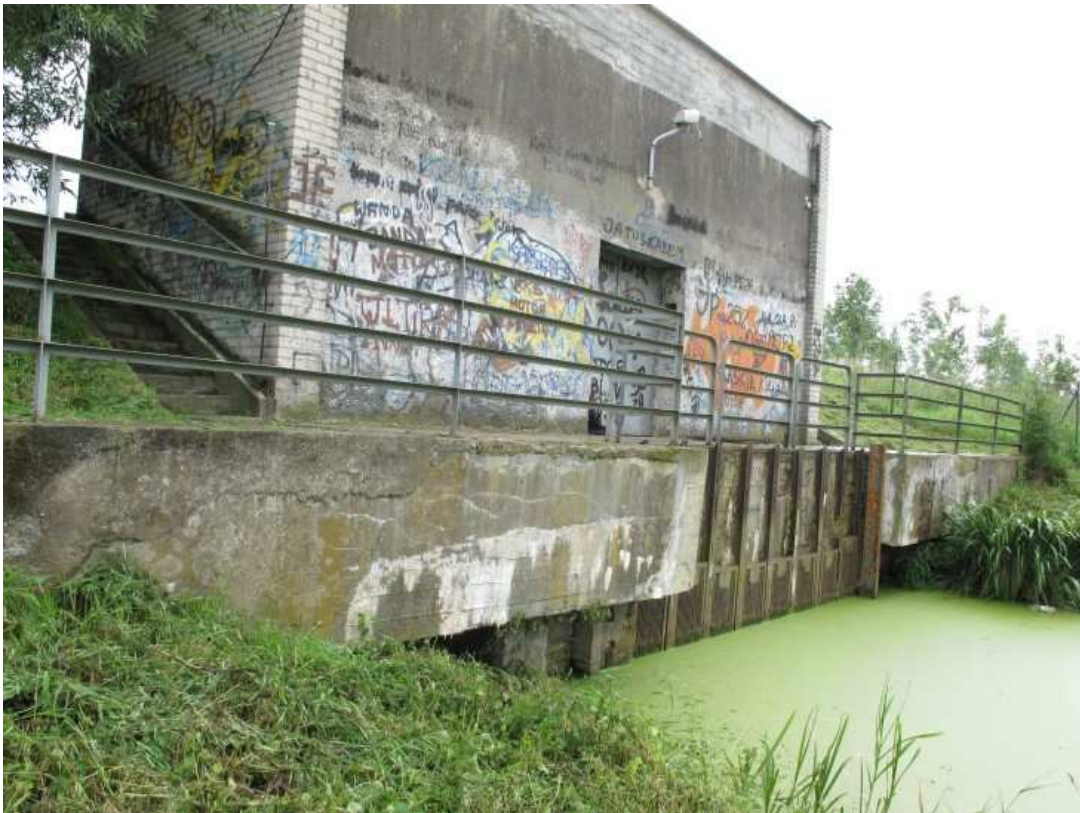
Fot. 16 Pompownia nr 2 Widok os strony zbiornika wyrównawczego
