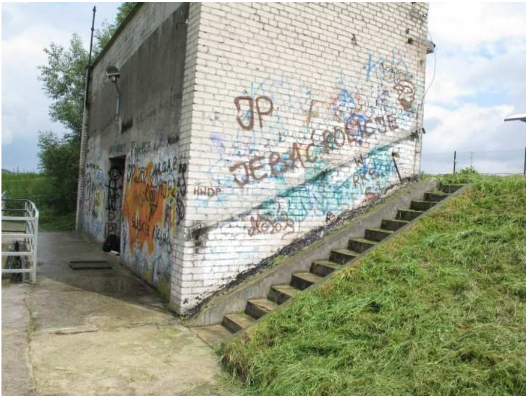
Fot. 13 Pompownia nr 2 budynek pompowni
