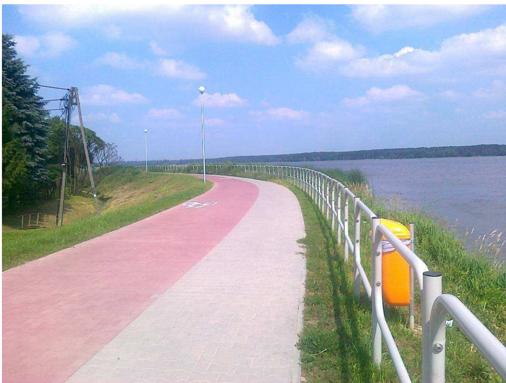
Fot. 2 Zapora lewa zbiornika
