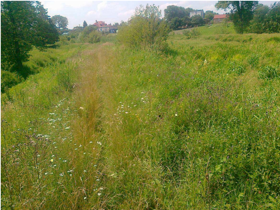
Fot. 6 Grobla wsteczna widoczne zarastanie grobli i międzywała przez roślinność
