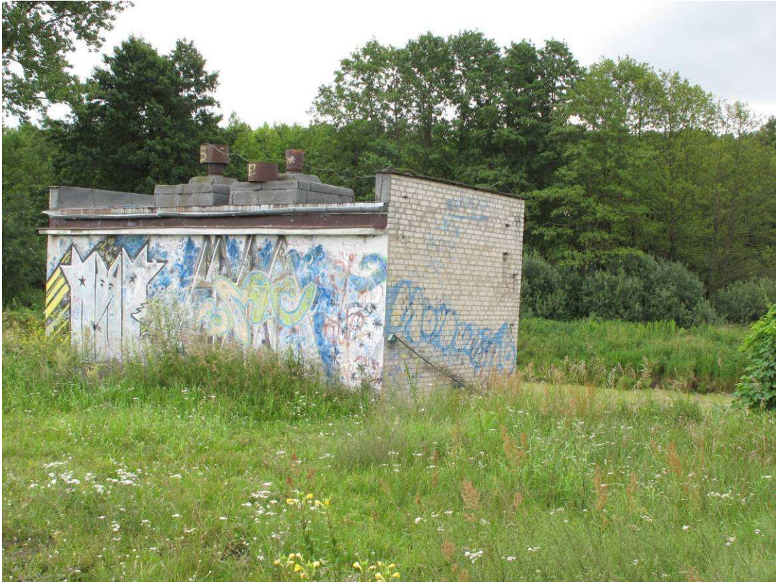
Fot. 7 Pompownia nr 1 - budynek pompowni
