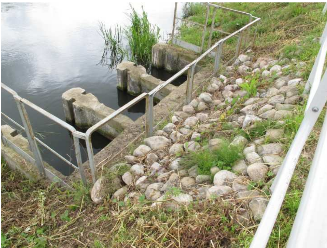
Fot. 14 Pompownia nr 2 -Dok wylotowy
